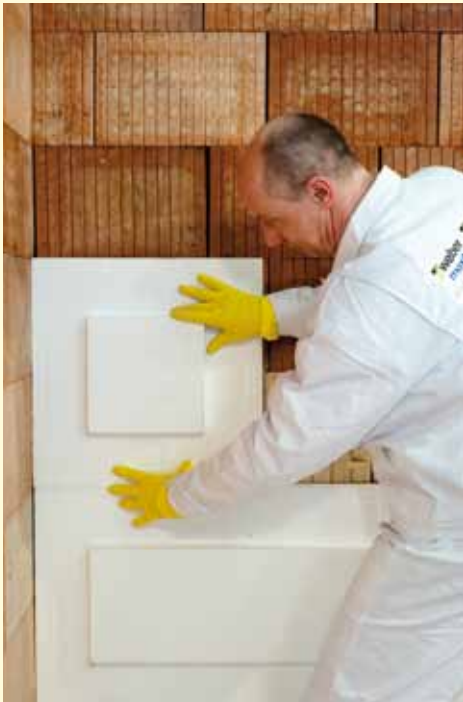
Die Plates werden wie herkömmliche Dämmplatten an der Fassade verklebt ...
