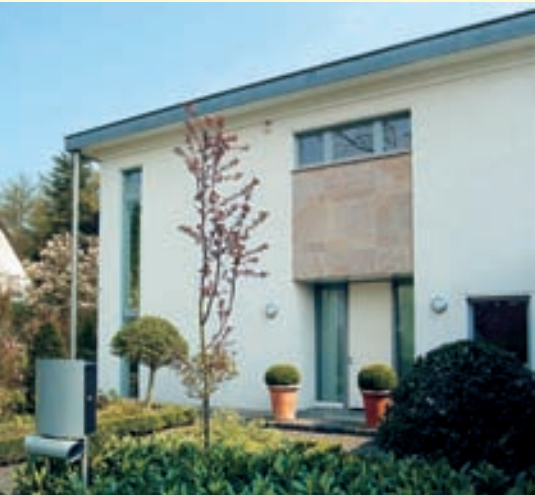
Langfristig schön – mineralisch gedämmte Fassaden überzeugen durch einen langen Werterhalt.
