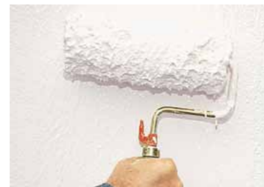
8. Die gesamte Fläche mit Haft-Sperrgrund grundieren.
