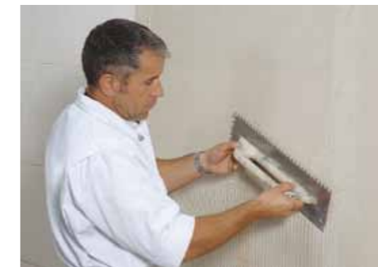
7. Das Armierungsgewebe anlegen und mit der Traufel einarbeiten.
