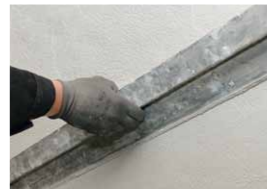
8. Anschließend flächiges Abziehen des Putzes über zuvor eingebaute Putzlehren und Abreiben des Sanierputzes mit dem mattfeuchten Schwammbrett (rot).
