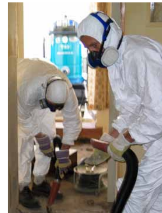
Atemschutzmasken verhindern das Einatmen der Schimmelsporen und beugen so einer Sensibilisierung vor.
