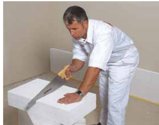
1. Die Dämmplatten lassen sich einfach und genau mit dem Fuchsschwanz zuschneiden.
