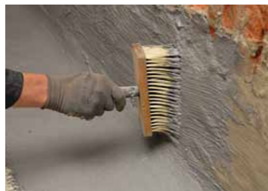
5. Die Innenabdichtung weber.tec Superflex D 2 wird je nach Wasserbelastung mindestens in zwei Lagen mit einem Quast aufgetragen.
