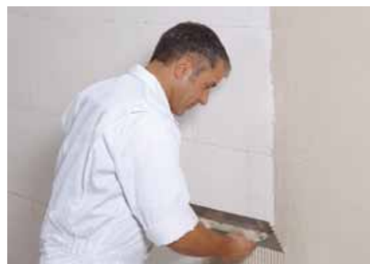
5. Versatzstellen nach dem Abbinden mit dem Schleifbrett leicht und schnell egalisieren.
