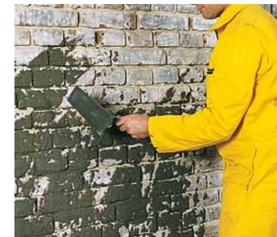
Schnellabbindender Spritzbewurf mit weber.san 951 S
