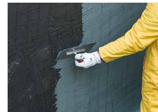
9. Nach Hautbildung der ersten Abdichtungslage erfolgt dann der Auftrag der zweiten Abdichtungsschicht mittels Schichtdickenkelle oder Glätter.
