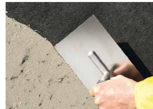
6. Der mineralische Sockel wird mit weber.prim 801 grundiert. Anschließend wird auf den vorhandenen Bitumenuntergrund eine Haftbrücke (Kratzspachtelung) mit weber.tec Superflex D 24 aufgetragen.
