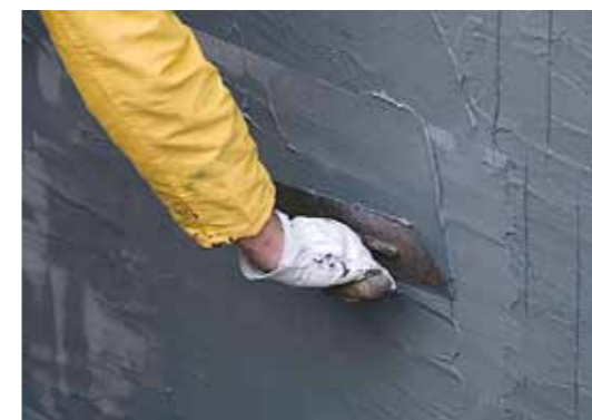
8. In die erste Abdichtungslage wird vollflächig das Glasgewebe webersys 981 eingespachtelt.
