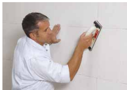
4. Das Dämmboard mit weber.sys 987 im Abstand von 2 cm zur vorigen Platte an die Wand ansetzen, an die Wandoberfläche andrücken und gegen die vorigen Platten einschwimmen.
