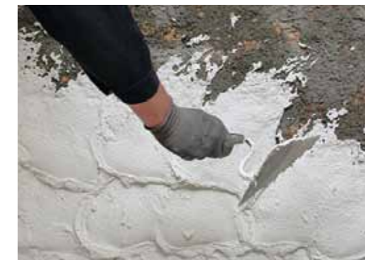
7. Auftragen des Sanierputzes weber.san 954 mit der Kelle.
