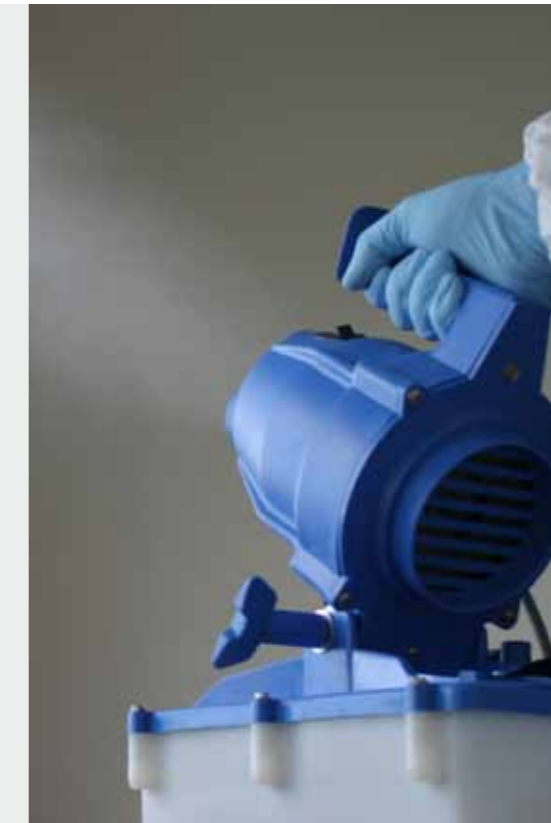
Aufsprühen des Schimmelpilzentferners weber.san Schimmel Ex auf die betroffenen Stellen.
