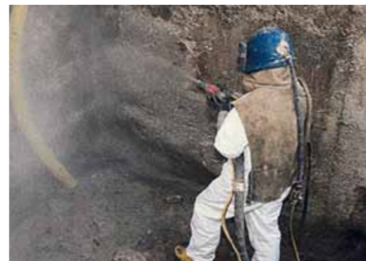
3. Da Teer kein geeigneter Untergrund für ein Abdichtungssystem ist, muss ein vorhandener Teeranstrich z.B. mit Sandstrahlen restlos entfernt werden. Gleiches gilt bei Bitumen ohne ausreichende Haftung zum Untergrund.
