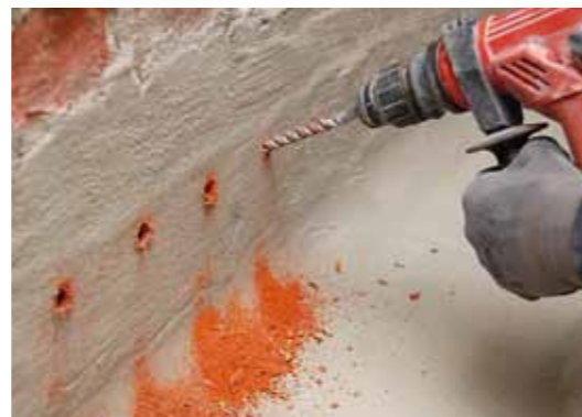
3. Nach Verdämmung mit weber.tec 933 Bohrlöchern unter einem Winkel von ca. 35°-45° und im Abstand von ca. 10-12 cm (Durchmesser ca. 12 mm) einbringen.
