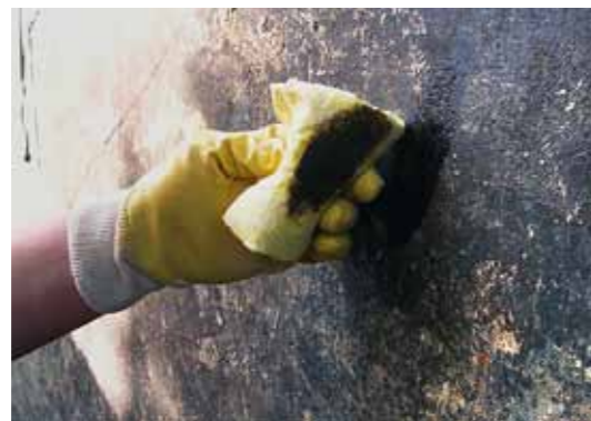
2. Zu Beginn der Arbeiten ist z.B. mit Testbenzin zu prüfen, ob es sich bei dem Altanstrich um Bitumen oder Teer handelt. Bitumen löst sich und verfärbt einen Lappen oder Schwamm, Teer dagegen nicht.
