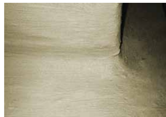
5. Am Fußpunkt wird die Hohlkehle aufgebracht. Hierzu wird der Mörtel in eine frische Haftbrücke eingebracht und ausgerundet. Der Fußpunkt wird dann komplett mit weber.tec 933 abgespachtelt.
