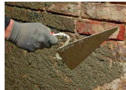
6. Den Spritzbewurf weber.san 951 S warzenförmig und mit 50 % Deckungsfläche mit der Kelle anwerfen. Bei voriger Überarbeitung des Untergrunds mit einer Dichtungsschlämme ist ein vollflächiger Auftrag notwendig.
