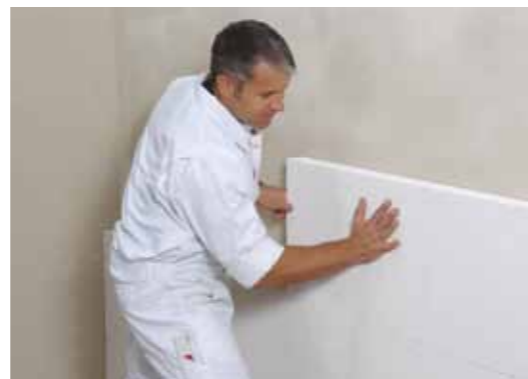
3. Bei einer Steghöhe des Leichtmörtels von ca. 8-10 mm können Unebenheiten im Untergrund ausgeglichen werden.
