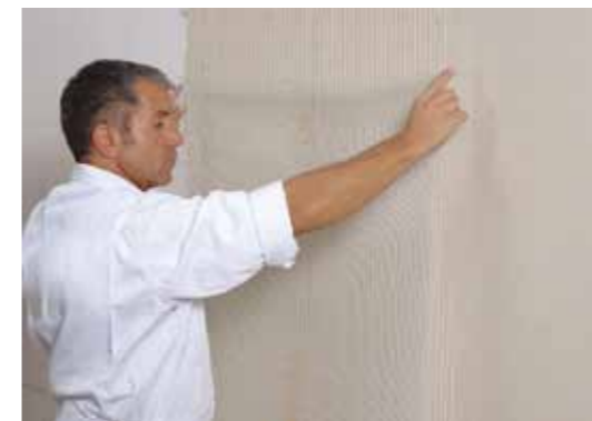
6. weber.sys 987 für die Armierungsschicht mit dem Zahntaufel auftragen.
