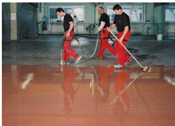
Bild 3: Einbau weber.floor 4650 DuroColour F 40
