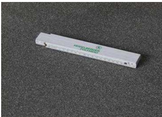
Bild 2: gleichmäßig abgesandete Epoxidharzgrundierung
