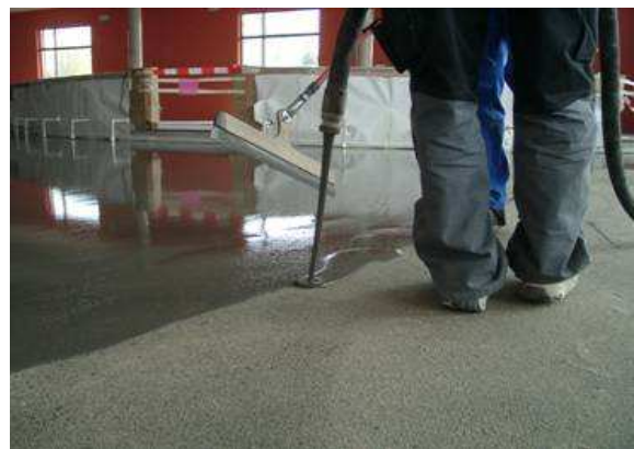
Bild 3: Einbau weber.floor 4650 DuroColour G 60 auf abgesandeter Grundierung
