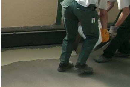
Bild 1: weber.floor 4753 Beschichtung PU ausgießen
